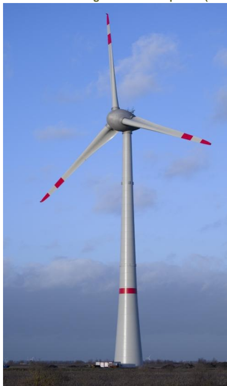
Figuur 3.1 Voorbeeld 5-8 megawattklasse op land (E-126)
